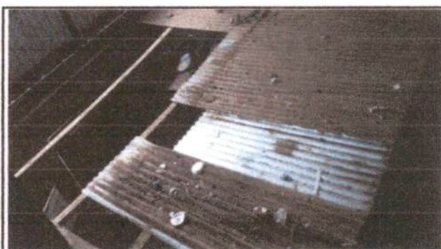
Foto 10 Techo y estructura de bodega
